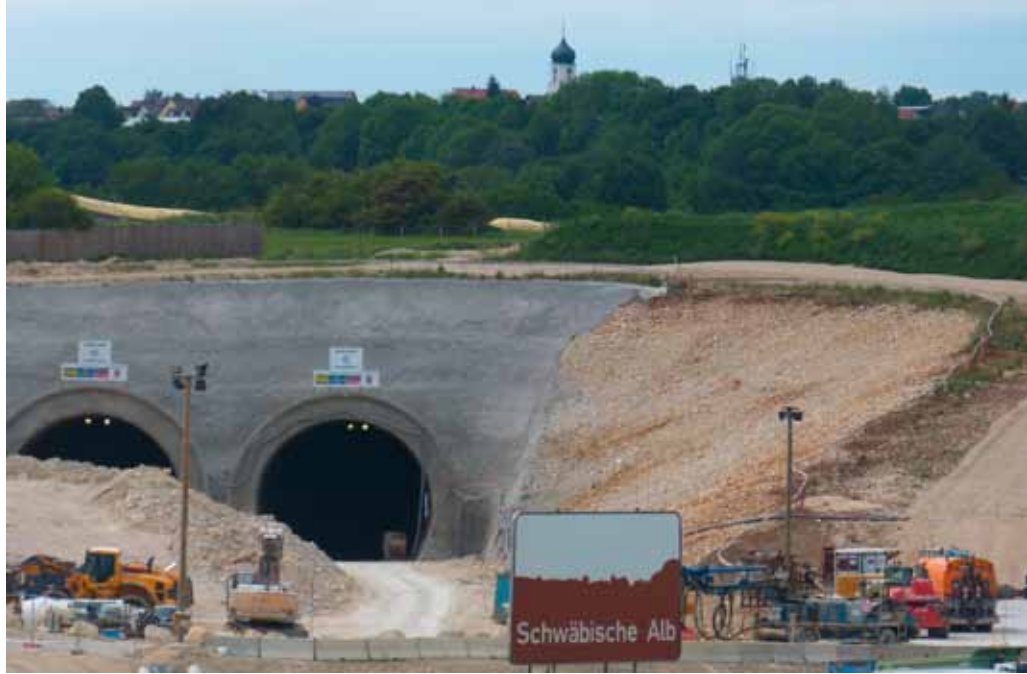
Fotos: Baustelle Steinbühlentunnel bei Hohenstadt (© wildrose.blogger.de)
