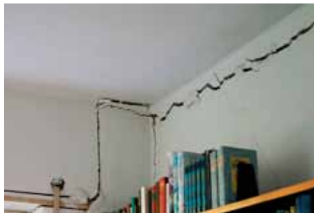
Horror für jeden Hausbesitzer: Senkungsrisse im Mauerwerk (Foto: Ulli Fetzer)
