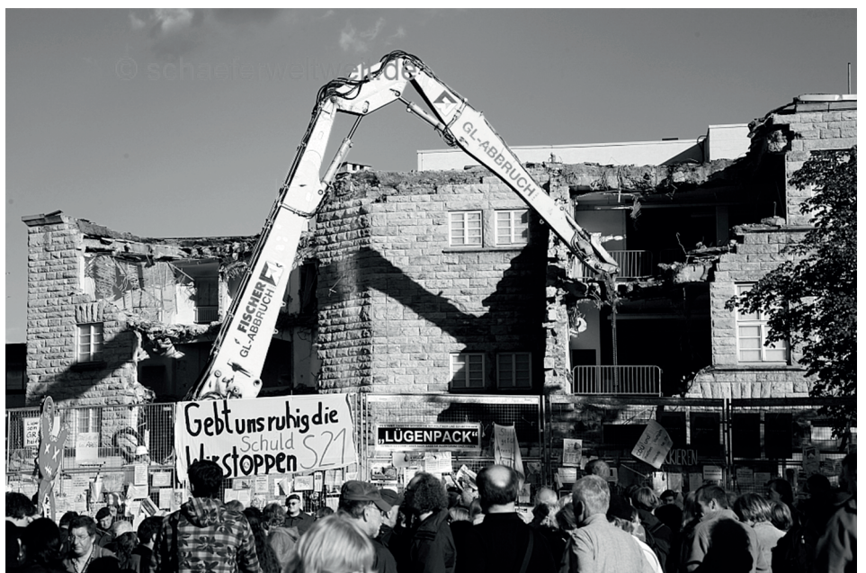
Abriss des Bahnhof-Nordflügels im August 2010. Bis heute ist das Gelände eine Baubrache. (Foto: Alexander Schäfer)
