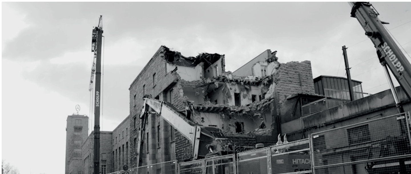
Erst zerstören, dann planen: schweres Gerät beim Abbruch des Bahnhof-Südflügels (Foto: Alexander Schäfer)
